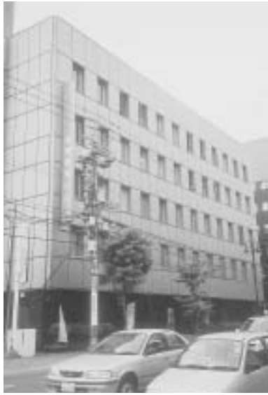
▲北電興業ビル
